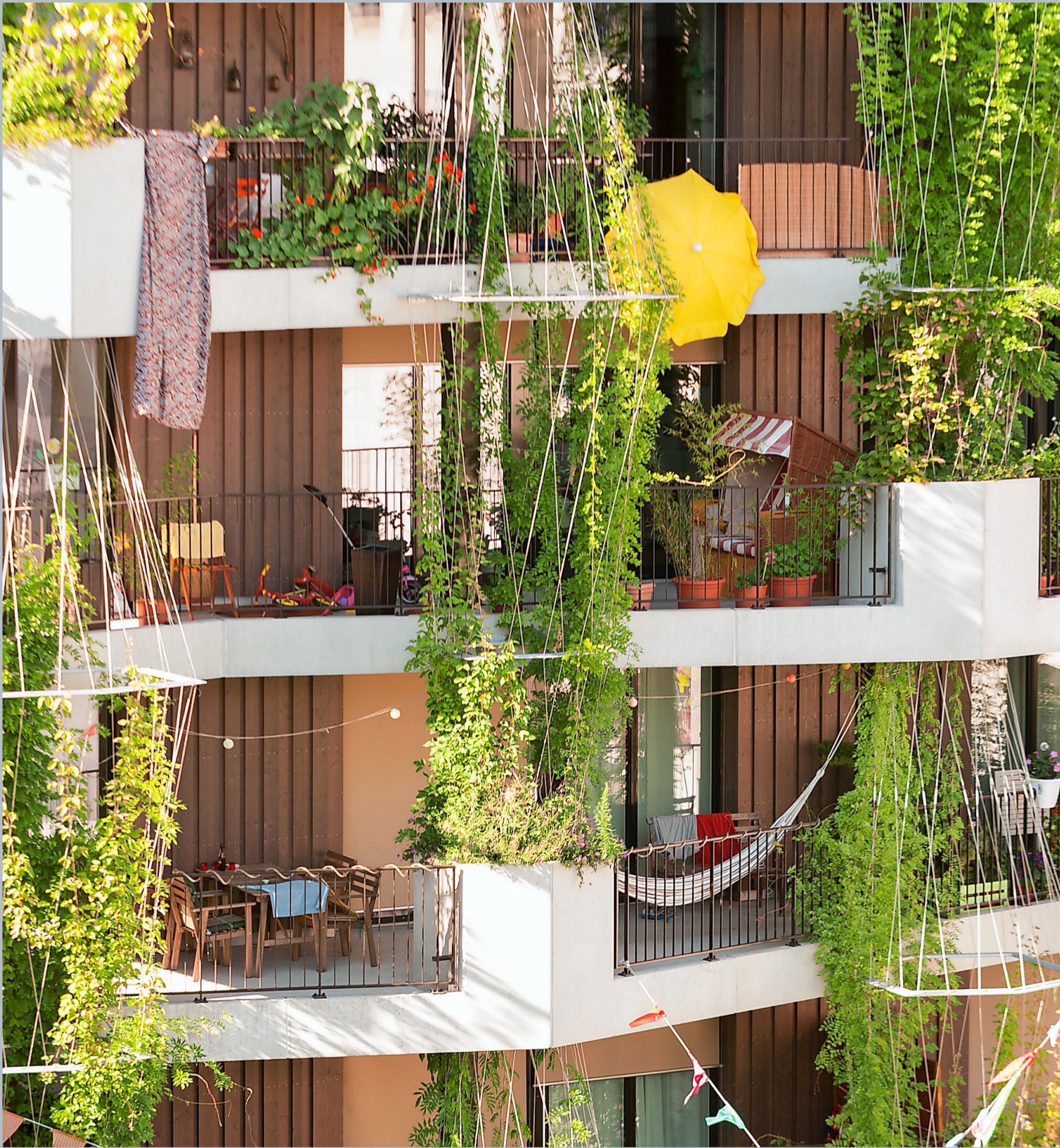
Hunziker-Areal in Zürich: Das 2015 eröffnete Areal wurde konsequent nach den Zielsetzungen der 2000-Watt-Gesellschaft geplant.
